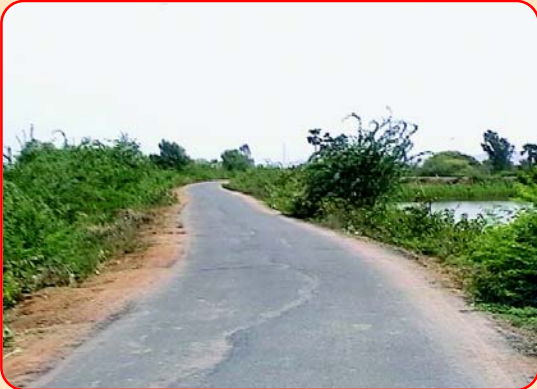
రూ. 20 లక్షలతో రామారావుపేట వద్ద నిర్మించిన అప్రోచ్ రోడ్డు.
