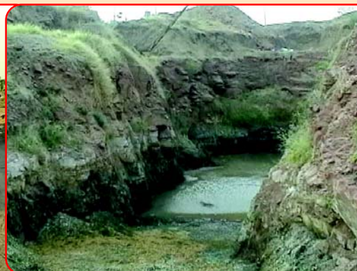
రామారావుపేట, ఇందారం గ్రామాలకోసం గోదావరినుంచి నీళ్ళందించే కోటి రూపాయల మంచినీటి పథకం (నిర్మాణంలో ఉంది)
