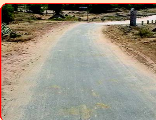
రూ.30లక్షలతో నిర్మించిన రామారావుపేట రోడ్డు
