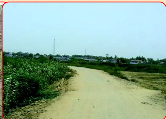
రూ.35 లక్షలతో నిర్మించిన కొత్తపల్లి రోడ్డు.
